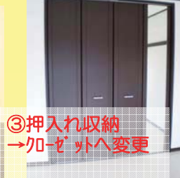
①ワッパドアの傷・汚れ→シート貼で保護 ②扉の傷・汚れ→シート貼で保護 ③押入れ収納→加ゼットへ変更
